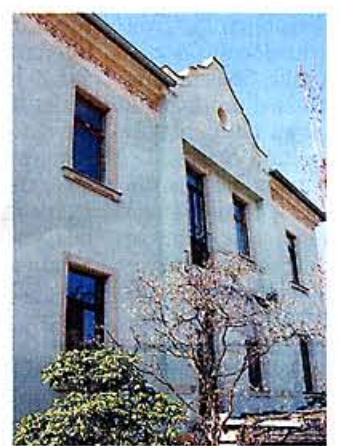
Beispiel einer perfekt sanierten Fassade.
